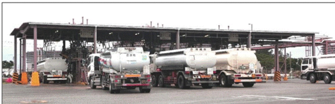
図2-29 ローリーラック全体
