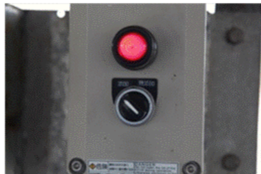
図 2-27 E3(添加)/一般レギュラー(無添加) 切換えスイッチ
