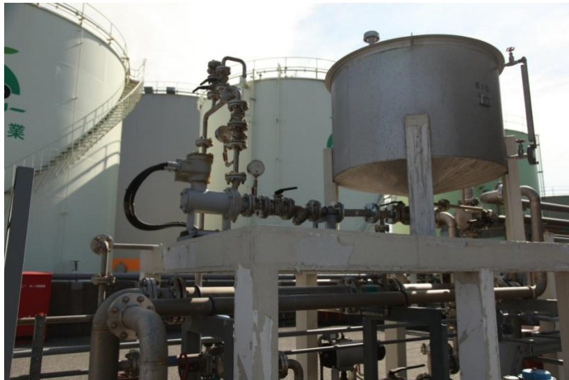
図2-36 ラインミキサーとE10製造用一時貯蔵タンク
