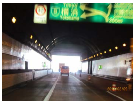
写真 1.4.1-2 大師トンネル内部
