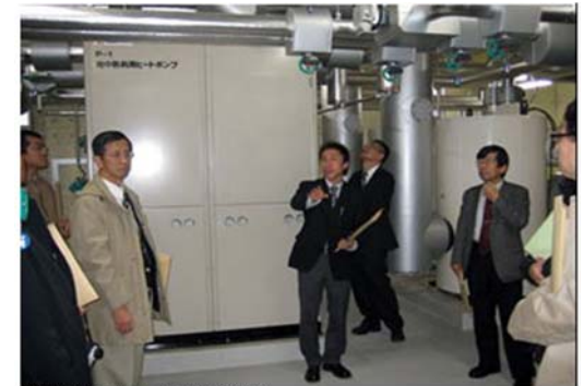
秋田市立山王中学校 機械室内の地中熱利用ヒートポンプ設備
