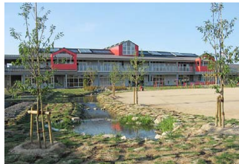
写真2.1.2-2 なのはな園外観 出典：「静里なのはな園」 8)
