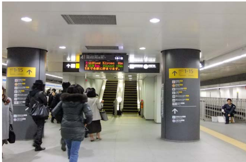
写真 2.1.2-9 地下鉄副都心渋谷駅ホーム改札用エスカレータ
