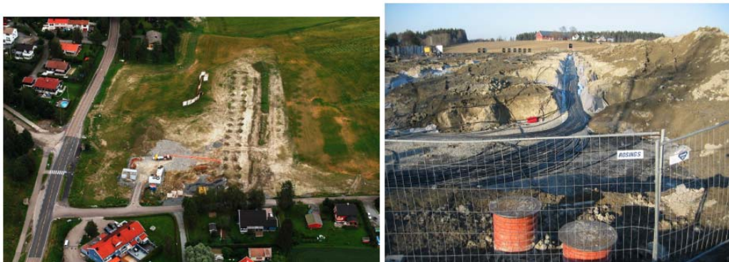
図2.1.2-16 ボーリング施工中の写真（左：全体図、右：パイプライン）
