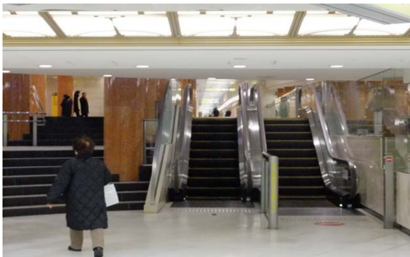
写真 2.1.2-1 三越日本橋本店地下通路のバリアフリー化 (再生事業を機に階段からエスカレータに変更)
