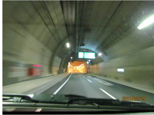
写真 1.4.1-4 山手トンネル内部
