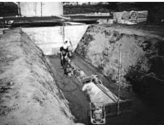
パイプライン実証実験
