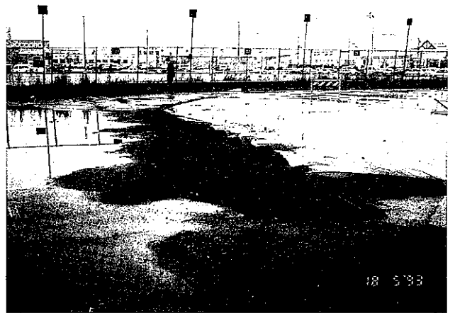
写真-14 ニチイ裏の駐車場での噴砂 —— 大規模に生じたクラックより噴砂が発生しており、 周辺地盤は沈下している。
