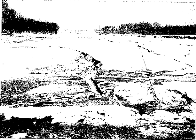
写真-1 庶路川、庶路橋下流 左岸の液状化と流動
