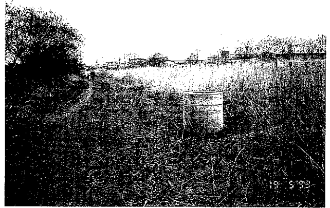
写真-13 マンホール (湿地の中)
