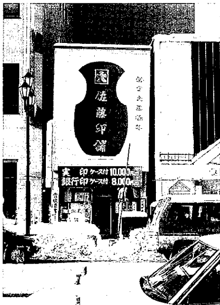
写真-10 釧路駅~幣舞橋の典型的な被害建物 —— 建物の1階部分が壊れ、向って右に傾いている。
