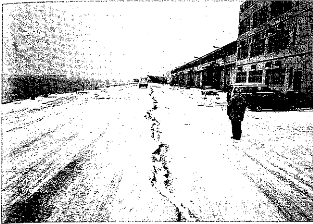
写真-7 釧路港副港 エプロンの亀裂 —— エプロンには、このように岸壁に添って亀裂が走った。
