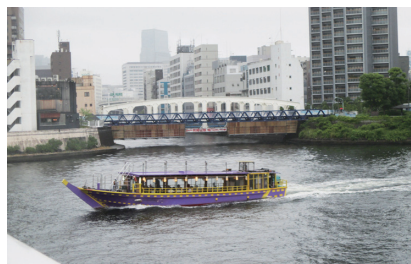
▲永代橋から豊海橋を望む
