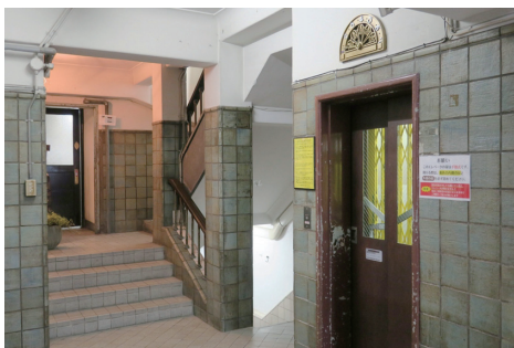
▲玄関ホールの手動式エレベーター
