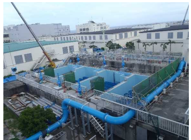
北谷浄水場の更新
