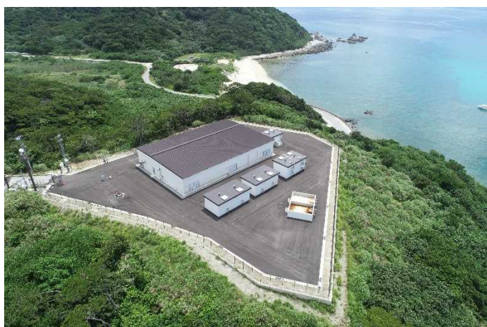
座間味村（阿嘉島）の海水淡水化施設
