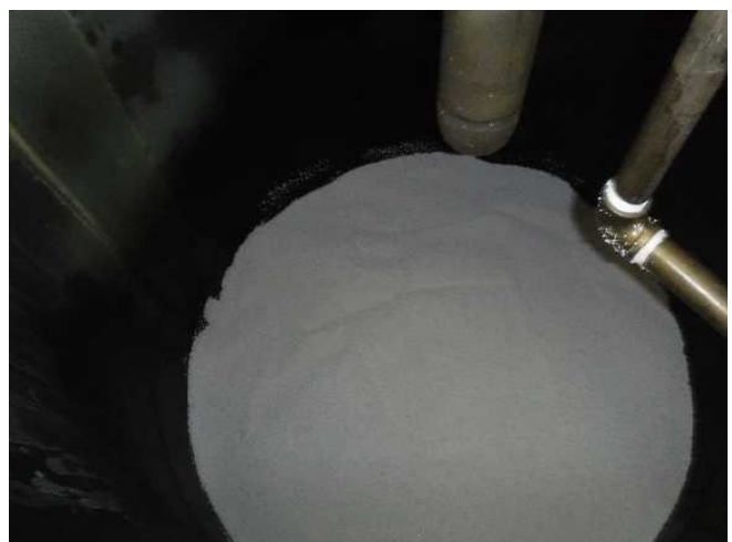
離島海水淡水化施設の ミネラル添加材として利活用
