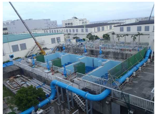
北谷浄水場の更新
