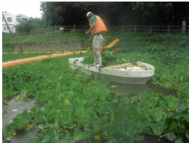
長田川浮き草除去
