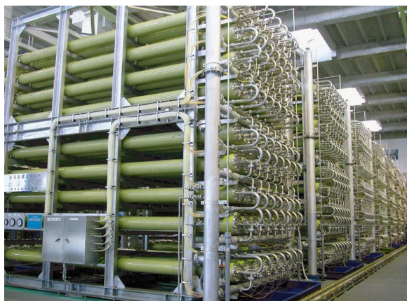
(写真) 海水淡水化施設の心臓部にあたる逆浸透設備
