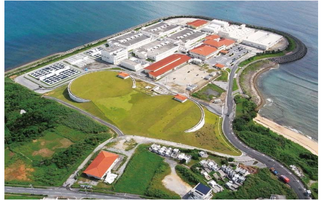
新石川浄水場建設状況(平成26年9月撮影)
