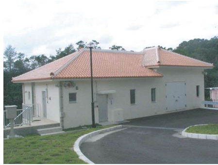
比謝川取水ポンプ場(嘉手納町)
