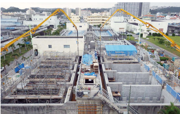
ろ過池工事の状況
