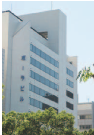
中京支社があるポーラ名古屋ビル
