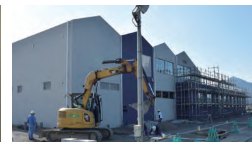
7月のオープンに向けて建設中の「UMIKARA」
