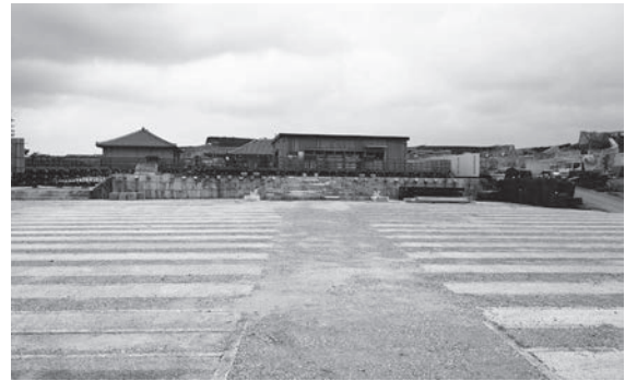
2022年度の正殿復元工事に向けて準備の進む首里城
