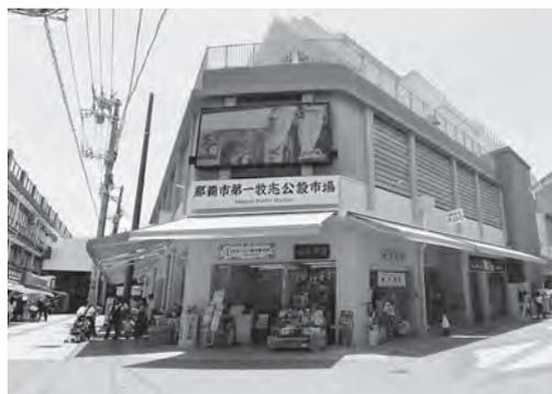
那覇市の第一牧志公設市場が3月19日にリニューアルオープンした。新市場の整備工事は、狭隘な道路や想定以上の軟弱地盤により困難を極めたが、関係者らの尽力によって無事完了。3年9カ月の歳月を経て新市場での営業を開始した。建物の規模はS+SRC造、地上3階、地下1階、塔屋1階、建築面積1543.86㎡、延床面積4981.31㎡規模。建設費は約36億7000万円。
