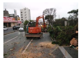
復旧作業 (風倒木処理)
