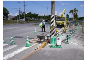
構造物の補修
