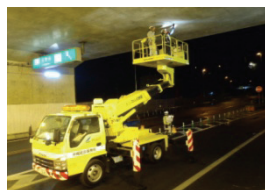
トンネル点検車
