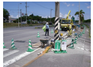
構造物の補修
