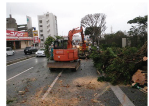
復旧作業 (風倒木処理)
