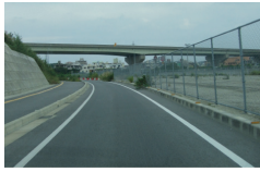
南風原バイパス 平成16年度部分 暫定供用区間
