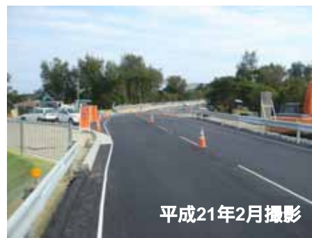
平成21年2月撮影 インター前整備状況
