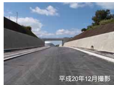
平成20年12月撮影 宜野座ドーム東側付近
