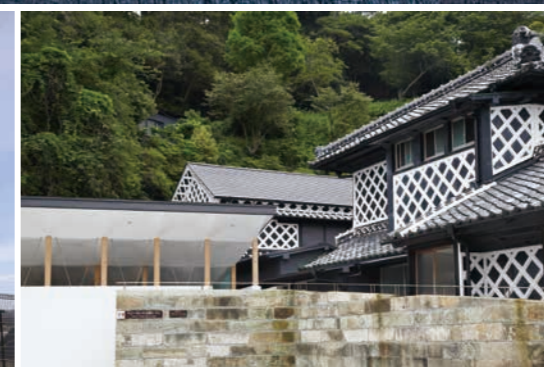
下田市・旧澤村邸の改修。地域特有のなまこ壁や伊豆石をデザインに生かしている。 撮影:堀田貞雄
