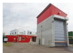
興部北興バイオガスプラント(北海道興部町)
