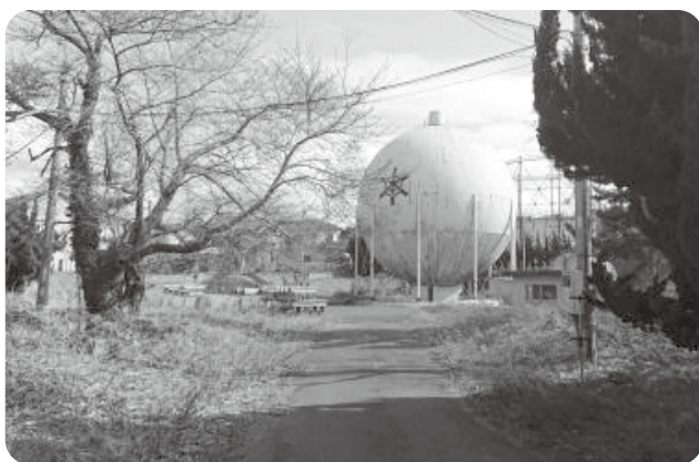
解体される水林旧ガス事業所施設
