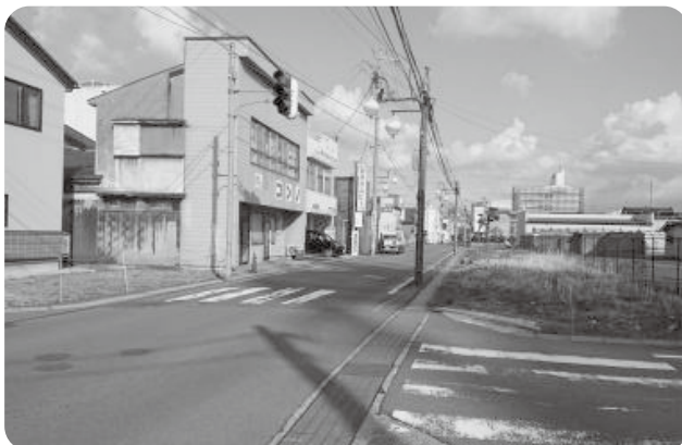
早期供用が望まれる停車場栄町線
