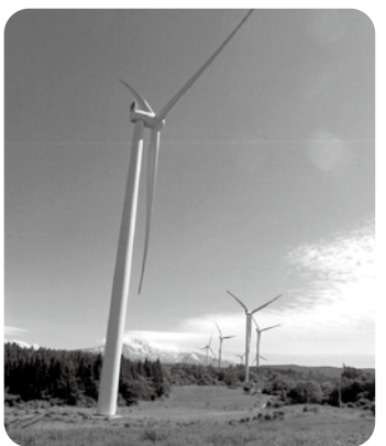
柵、フェンス、施錠のない風車群
