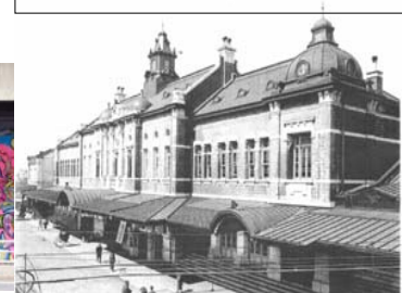
旧東横線高島町駅近くにあった「2代目横浜駅」
