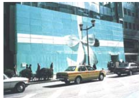
工事用仮囲いのグラフィックス
