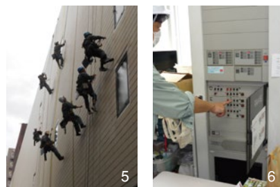
3:樽町ポンプ場外壁改修 / 4:十日市場保育園園屋上防水改修 / 5:外壁調査 (公財) 横浜市建築保全公社提供 / 6:防火設備点検 (公財) 横浜市建築保全公社提供
