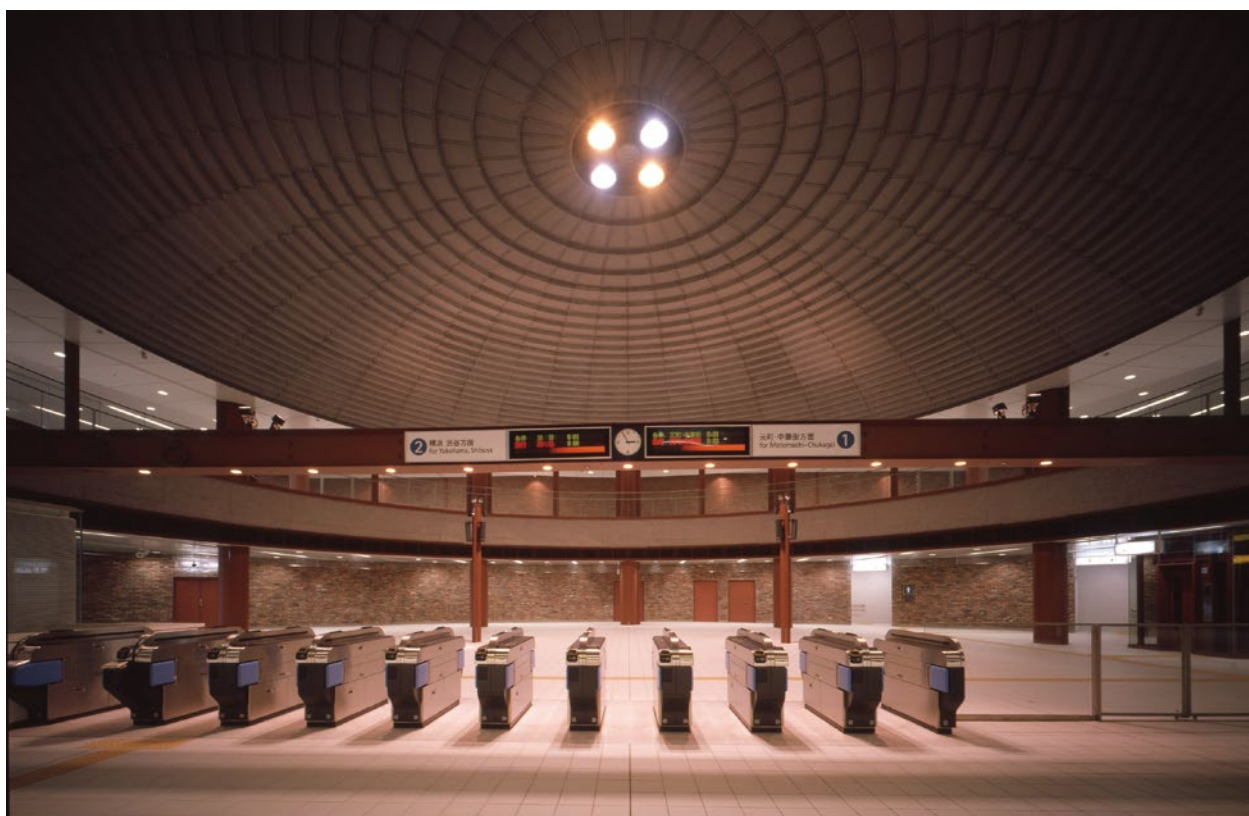
みなとみらい線馬車道駅中央にあるドーム状のホール。天井には音響や雨漏りに配慮した材料を使用している。(内藤廣建築設計事務所提供)
