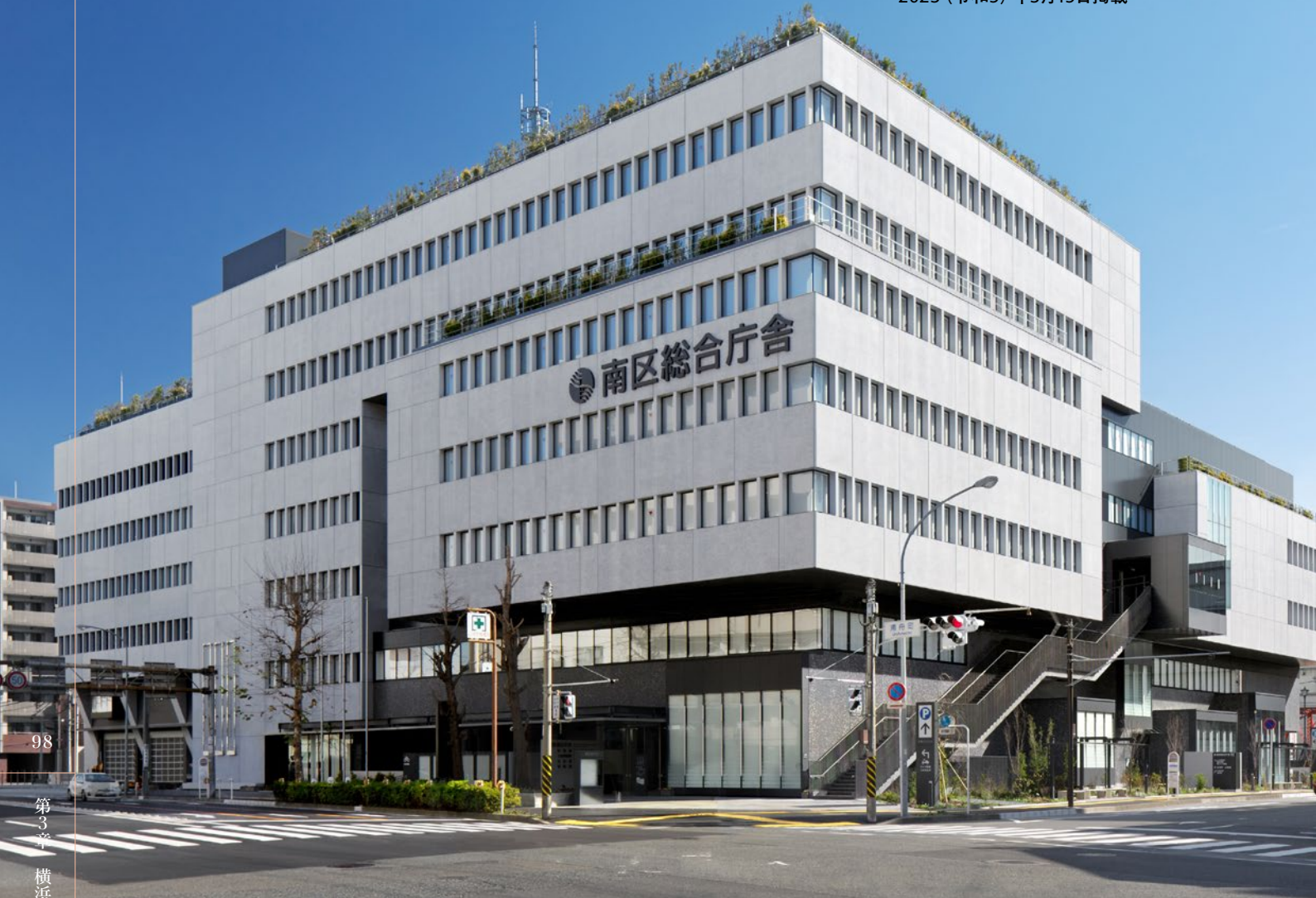
外観。区役所、消防署、土木事務所、公会堂が一体となった複合施設
