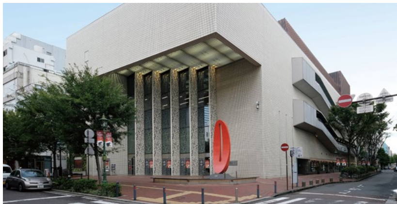
上：外観／下：大ホール
