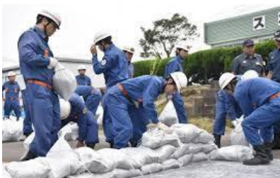
ど こうちく 【土のう構築】
