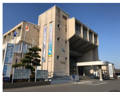
つくばみらい市役所 谷和原庁舎
