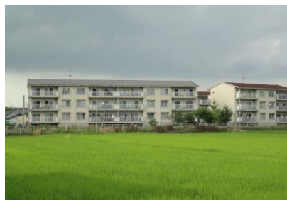
古川住宅 鉄筋
