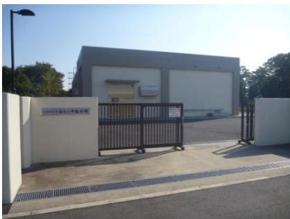
みらい平配水場
