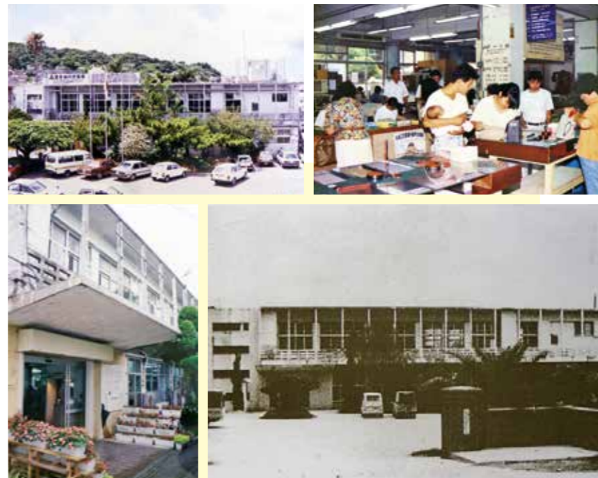
鉄筋コンクリート2階建ての村役所庁舎が完成(昭和33年5月) —新庁舎(宜保1丁目)の向かい側の敷地に建設され、平成14年の翁長庁舎に移転するまで使われていました。
