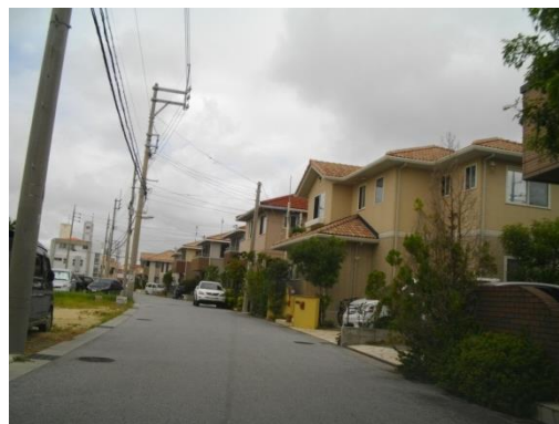
地区計画等によって整ったまちなみがつくりだされ、まちの魅力が高まっています。しかし、建築後の増築などで違反物件があることから、ルールの周知やその対策を含め良好な景観形成に向けた取り組みが必要です。(写真:豊崎)
