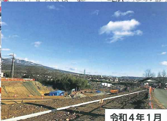
上田市国分地区工事進捗状況 (昨年比較)
