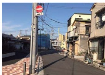
京島地区の防災まちづくり (主要生活道路の整備)
