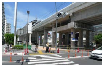
京成線の連続立体交差事業
