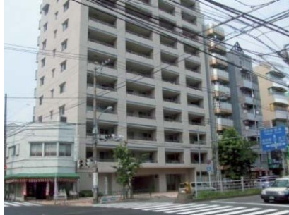
集合住宅の建設
