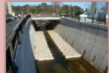
豪雨対応の護岸改修
