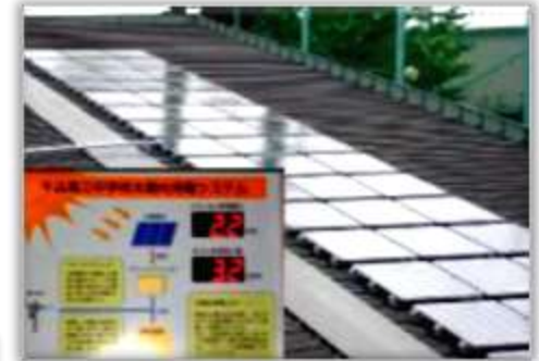
太陽光パネルの設置
