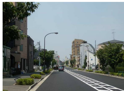
整備が完了した補助 46 号線 (小山台一丁目付近)
