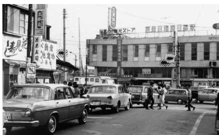
東西のまちを分断する踏切 (東急目黒線目黒駅、昭和40年)
