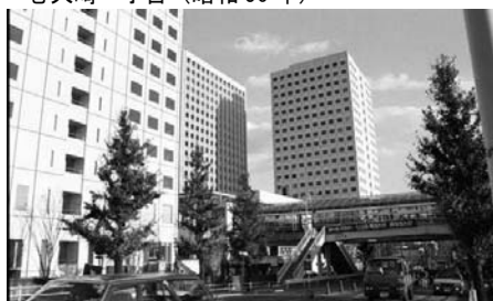
再開発事業により整備された〇歩道橋（昭和 61 年）
