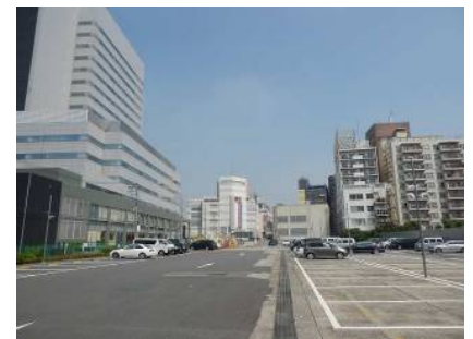
市街地再開発事業が進められている目 黒駅前地区
