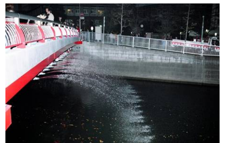
御成橋に設置された放水施設
