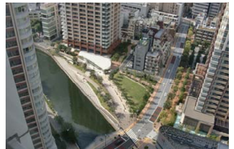
護岸を切り下げて親水化が図られた五反田ふれあい水辺広場
