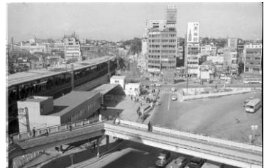
整備が完了した当時の五反田駅前広場（昭和42年）
