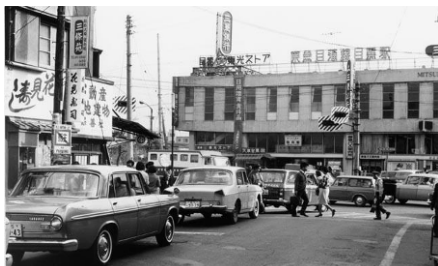
東西のまちを分断する踏切 (東急目蒲線目黒駅、昭和40年)
