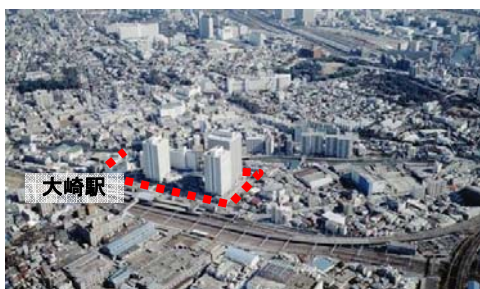
先頭を切って市街地再開発事業が完了した大崎ニューシティ（昭和 61 年）
