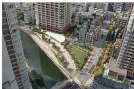
護岸を切り下げて親水化が図られた五反田ふれあい水辺広場
