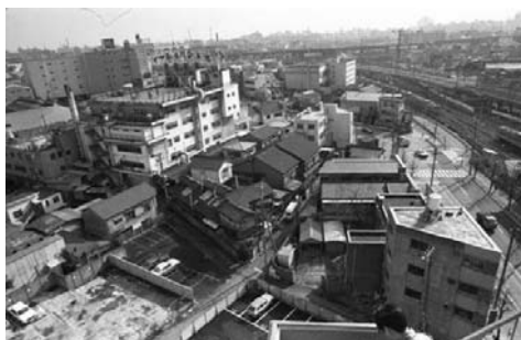
路外駐車場への暫定利用など工場の減少が進む大崎一丁目（昭和 56 年）
