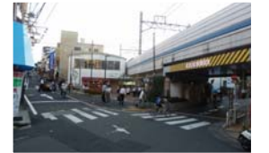
踏切が除却された不動前駅
