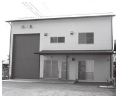
▲完成した栄町集会所
