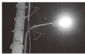
LED照明を設置
