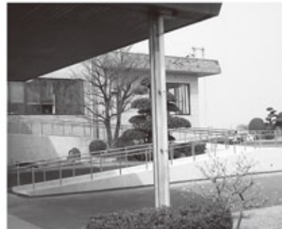
▲完成したスロープ
