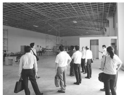
▲ホーチミン市で建設中のレンタル工場を視察
