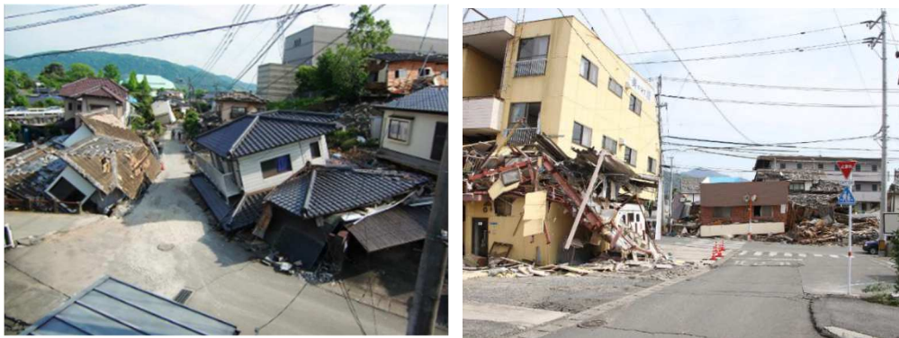
図 平成28年熊本地震による建築物の被害（熊本県益城町） 出典：熊本地震デジタルアーカイブ
