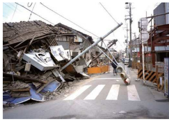
図 建物倒壊による道路閉塞のイメージ 出典：国土交通省
