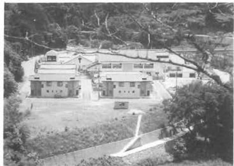
着々と整備が進む 道野尾公営住宅
