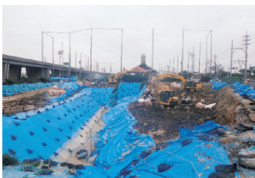
駐車場側の一部を埋戻し、未掘削だった県道沿いの駐車場側について、経層磁気探査が行われました。
