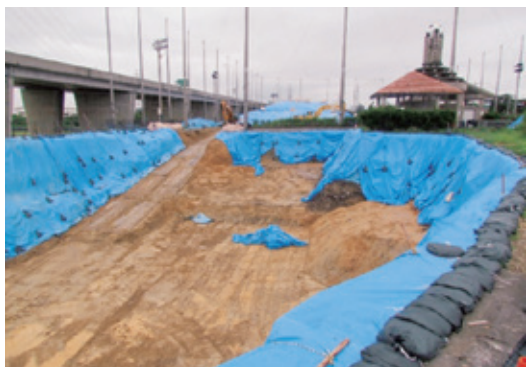
経層磁気探査完了後の駐車場側付近
