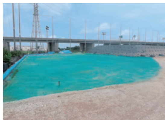
汚染土壌等を全て掘削し、購入土で埋戻しを完了したグラウンド側
