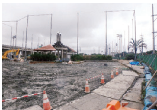
経層磁気探査が完了後、購入土等で埋戻しが行われました。
