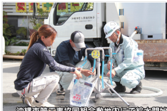
沖縄市管工事協同組合敷地内にて給水開始
