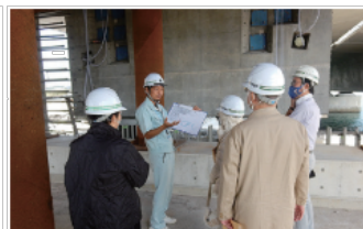
東部海浜埋立地区の工事現場視察
