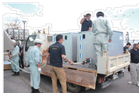
配水池にてタンク設置、補給
