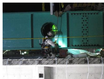
仮設桁を解体する作業員
