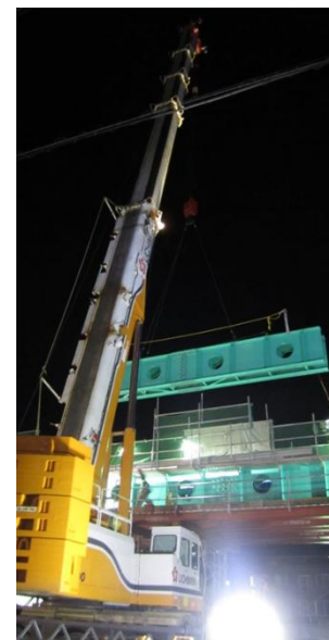
仮設桁を吊り上げる様子 (手前は200t油圧クレーン)
