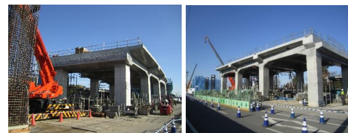
駅部高架橋の様子
