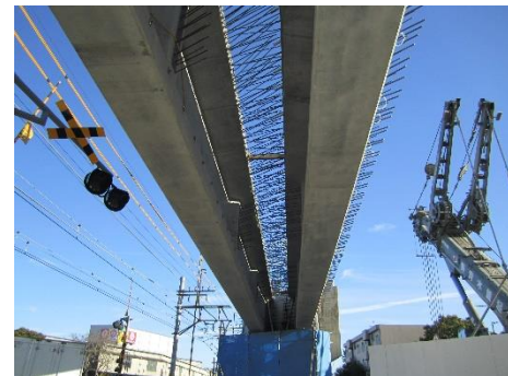
第168号踏切高架橋真下の風景
