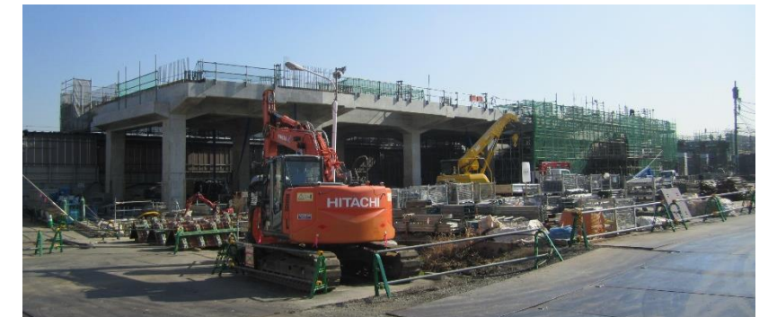
現在の駅部施工状況
