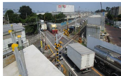
第168号踏切側高架橋上より撮影
