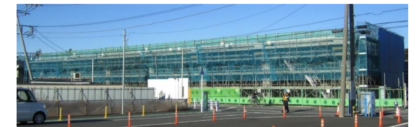
野田市駅部施工状況
