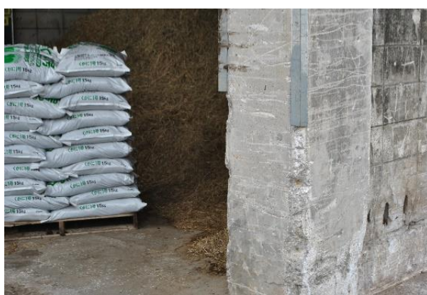
堆肥製造施設 外壁
