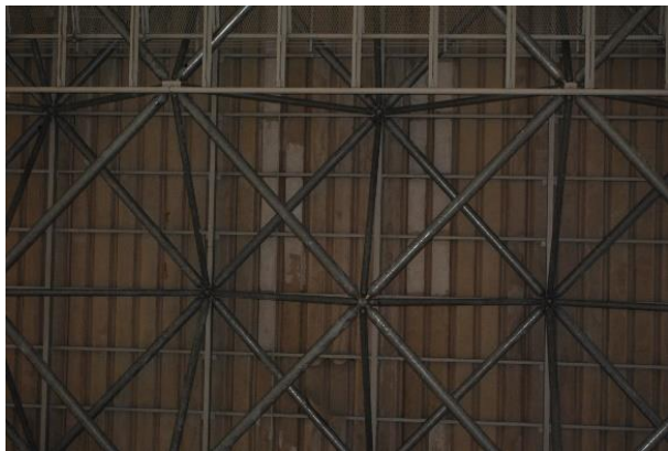
玉城総合体育館 天井
