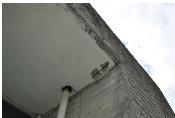
伊原区学習等供用施設 外観
