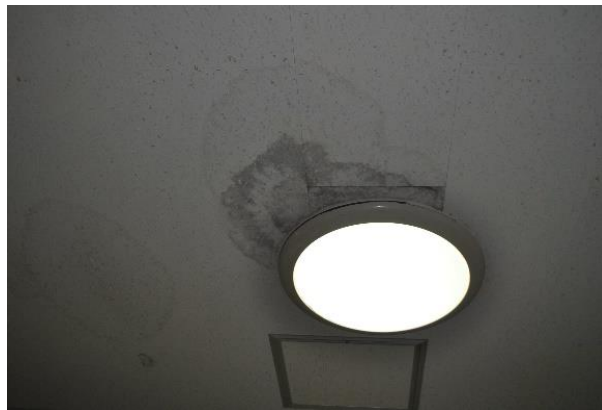
知念体育館 廊下部分 天井
