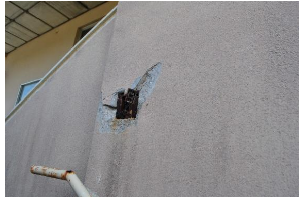
がんじゅう広場 外壁
