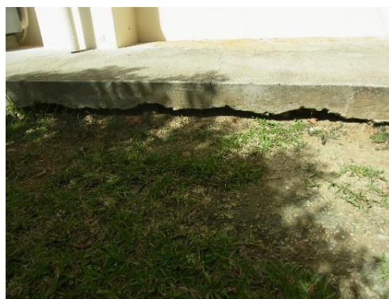
中央公民館 基礎（一部）
