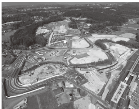
リニア岐阜駅(仮称)建設工事などの状況 (5月17日撮影)
