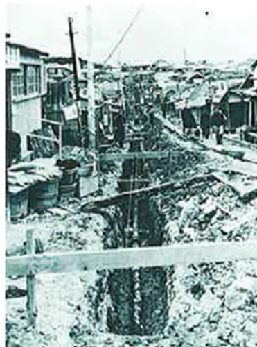
開南中央通り簡易水道配管工事
