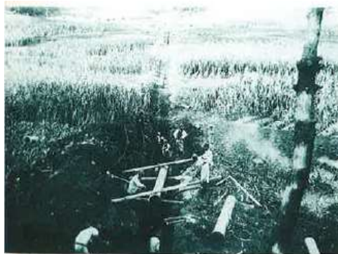
送水管 300m/m 布設風景
