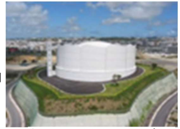
安里配水池 有効容量 13,300 m 3
