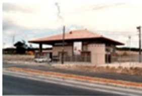
垣花ポンプ場
