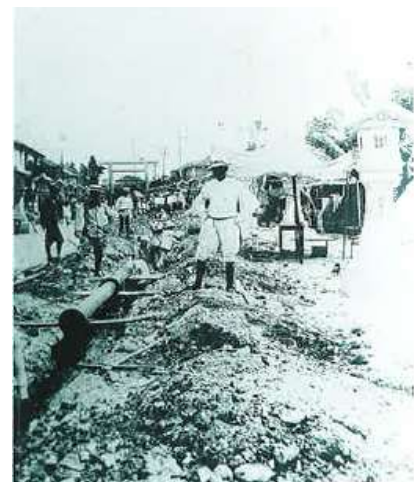
波の上一带配水管埋設工事
