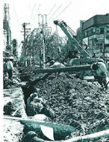
国際通り大越百貨店前(平和通り入口前)配水管工事風景
