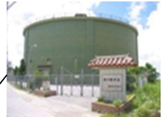
新川配水池 有効容量 8,000 m 3
