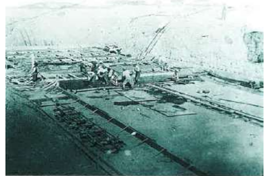
1932.7 泊浄水場配水池建設風景
