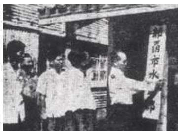
水道部の看板を掲げる新垣助役
