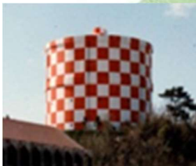
赤嶺配水池 有効容量 4,000 m 3
