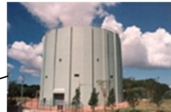
真地配水池 有効容量 3,300 m 3
