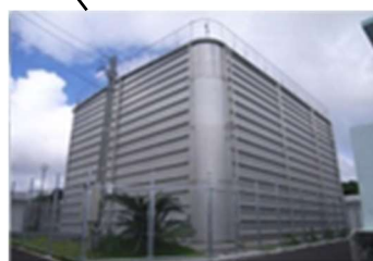
上識名配水池 有効容量 1,500 m 3
