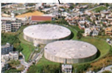
上間配水池(県)
