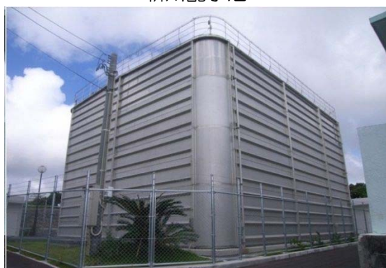
上識名配水池
