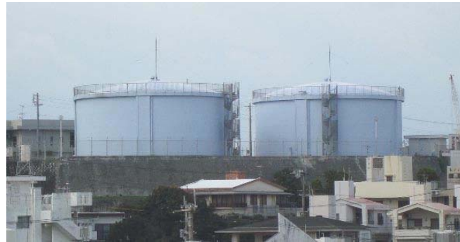
豊見城配水池
