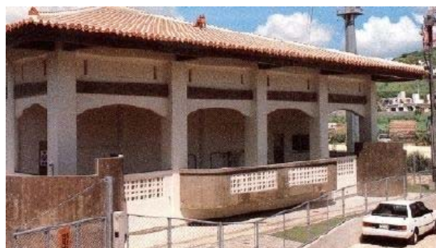
豊見城ポンプ場
