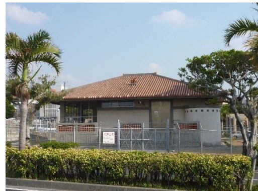
垣花ポンプ場
