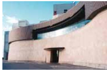
海水淡水化施設
