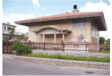
石嶺ポンプ場
