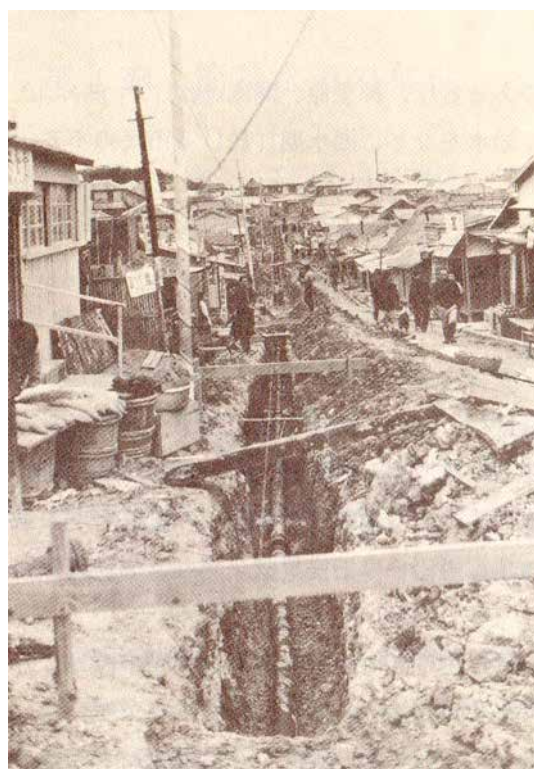
簡易水道配水管工事 (昭和26年)
