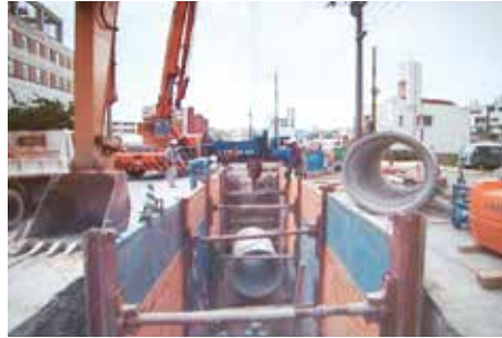
雨水管工事
