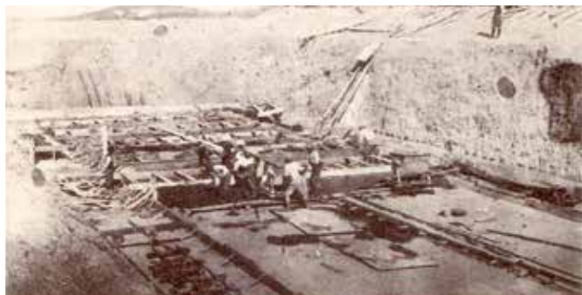
泊浄水場建設工事のようす (1932年(昭和7年)4月)
