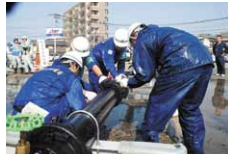
↑ 配水管修繕訓練 3
