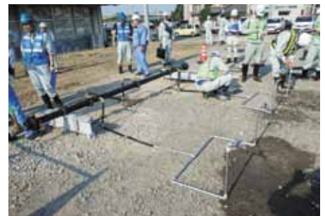
↑ 仮設給水栓設置訓練
