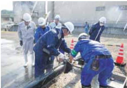
↑ 配水管修繕訓練 1
