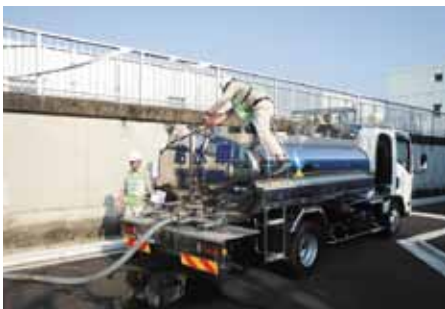
↑ 給水車水道水補給訓練
