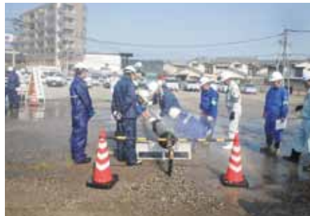
↑ 配水管修繕訓練 2
