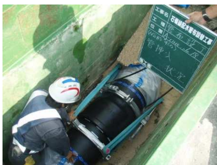
耐震管(NS形 φ450)の管接合の様子
