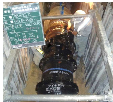
耐震管布設工事の様子
