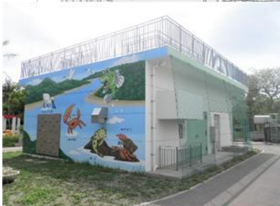
古波蔵雨水ポンプ場
