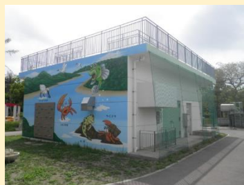
古波蔵雨水ポンプ場 平成21年度（2009年度）供用開始
