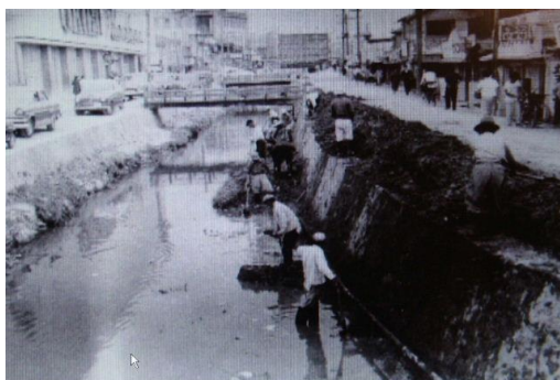
カーブ川の布設工事
