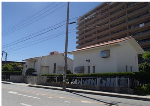
●赤嶺汚水中継ポンプ場
