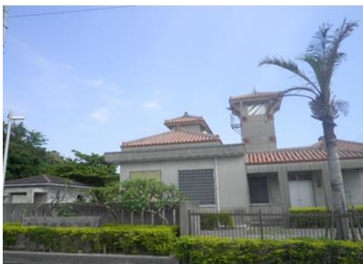
●具志汚水中継ポンプ場
