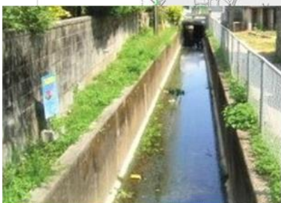
●小禄1号幹線 (排水路)
