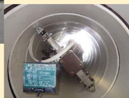
長寿命化(更生工法)工事
