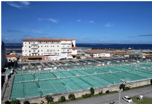
●那覇浄化センター（沖縄県施設）
