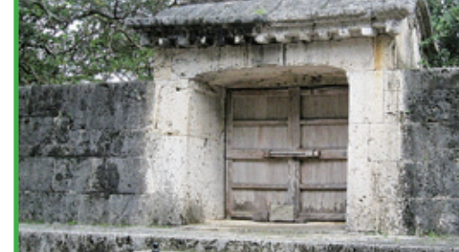
⑨園比屋武御嶽石門(首里当蔵町) 戦争中に一部破壊されたが、1952年に復元されました。現在は世界遺産群の一つです。復元建造物が世界遺産に登録された理由として、園比屋武御嶽石門の右側上部の一部は、破壊前の建材を使用しており、可能な限り破壊前の状態に戻したことがあげられます。貴重な文化財が戦争によって破壊された悲しさを見ることができます。
