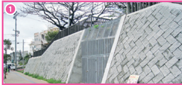
①希望ヶ丘公園内の壕(牧志) 希望ヶ丘公園内にある自然壕で入口は3カ所あります。写真は、なほテンプス館横の通り沿いにある入口で、道路拡張工事中に発見されました。
