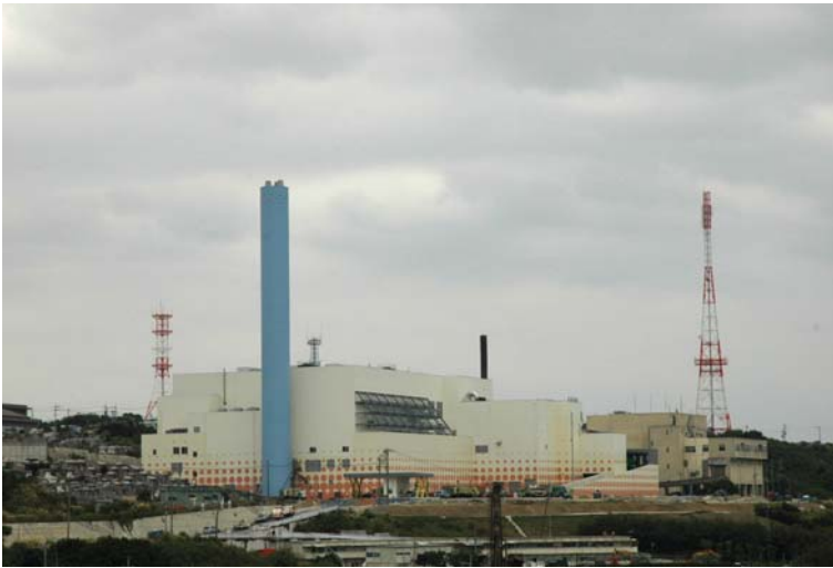
廃棄物発電装置をそなえた新ごみ処理施設「那覇・南風原クリーンセンター」が稼働
