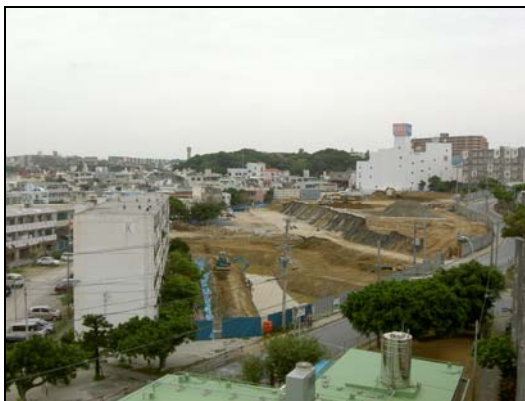
久場川市営住宅建替事業造成工事 Kubagawa Municipal Housing Reconstruct Project site
