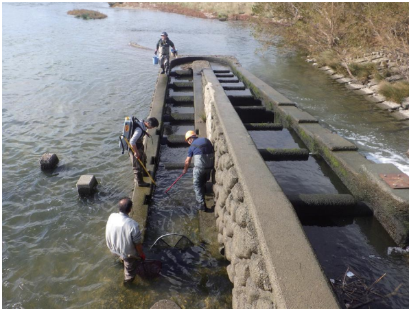
図2. 右岸側の階段式魚道
