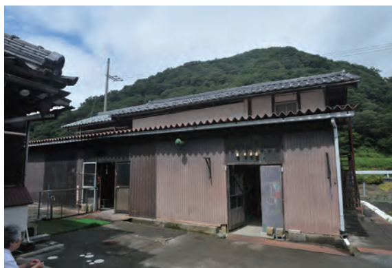
写真 3-4-6 土蔵+隠居屋 (003-2) 外観 (西側)
