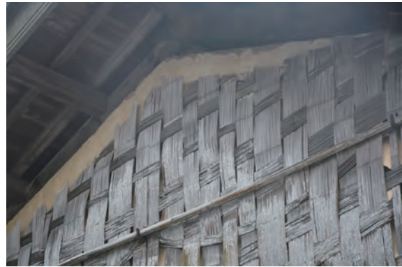
写真 3-4-57 土蔵 (044-4) 壁面のゴザ目の竹菱木
