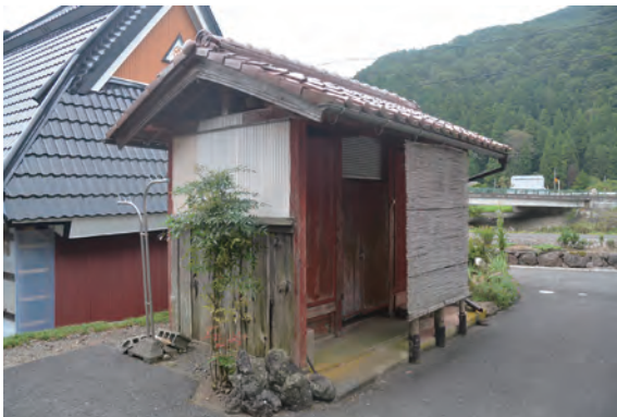
写真 3-4-60 便所 (044-2) 外観 (北側)
