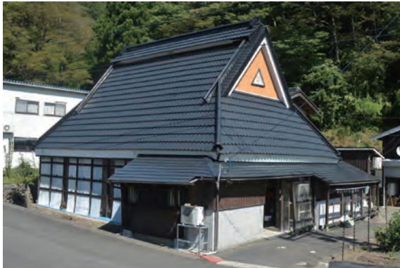
写真 3-4-61 主屋 (045-1) 外観 (南側)
