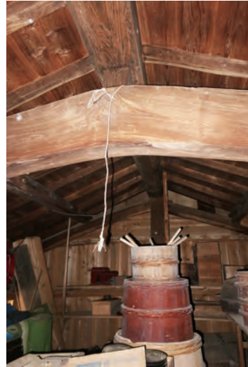
写真 3-4-91 洞壽院・土蔵 小屋組
