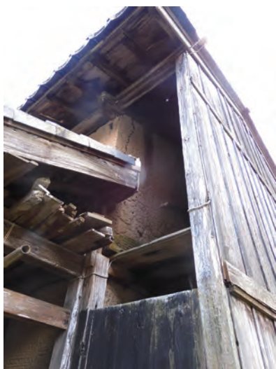
写真 3-1-7 ケラバ下を内部化した土蔵 (056-3)
