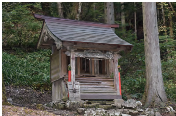
写真 3-4-94 洞壽院・稲荷神社 外観（南側）
