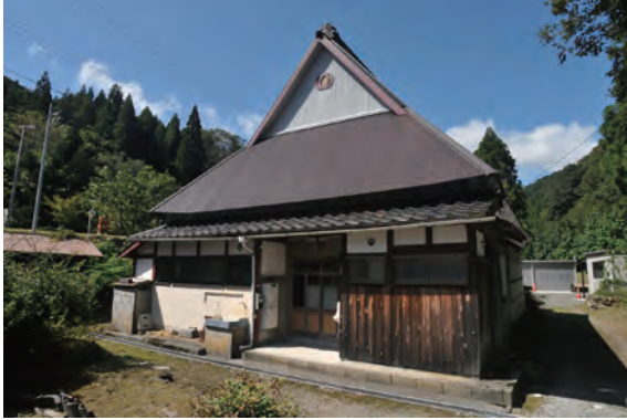
写真 3-4-69 主屋 (056-1) 外観 (南東側)
