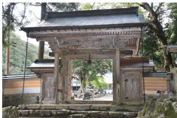
写真 3-4-95 洞壽院・山門 外観（東側）
