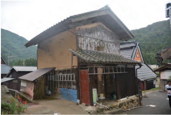
写真 3-4-56 土蔵 (044-4) 外観 (北側)
