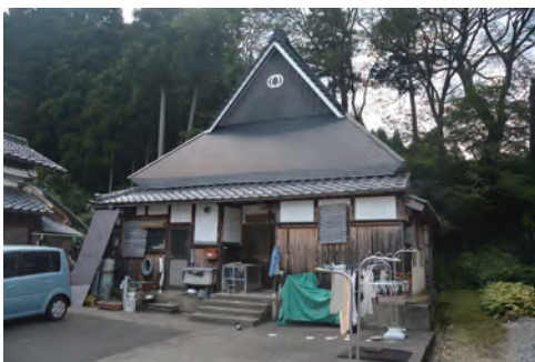
写真3-4-13 主屋（010-2）外観（南東側）
