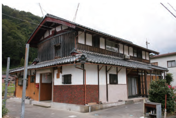
写真 3-4-35 主屋 (027-1) 外観 (南東側)
