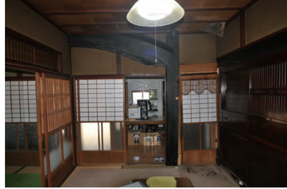
写真 3-4-70 主屋 (056-1) 大黒柱と十字梁
