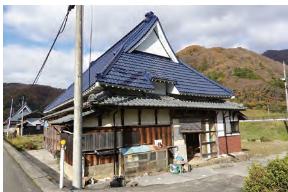
写真 3-4-49 主屋 (042-1) 外観 (南側)
