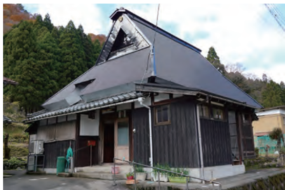
写真 3-4-24 主屋（020-1）外観（南東側）
