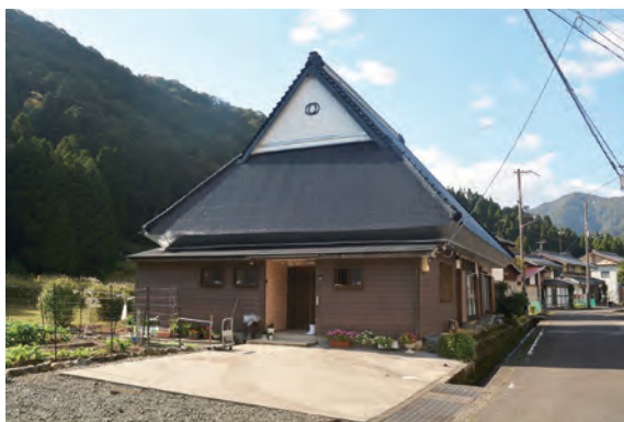
写真 3-4-39 主屋（029-1）外観（南東側）
