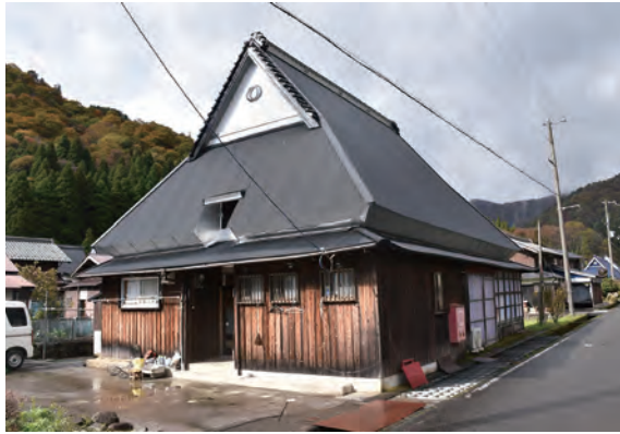
写真 3-4-1 主屋 (002-1) 外観 (南東側)
