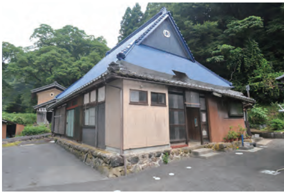
写真 3-4-54 主屋 (044-3) 外観 (南側)
