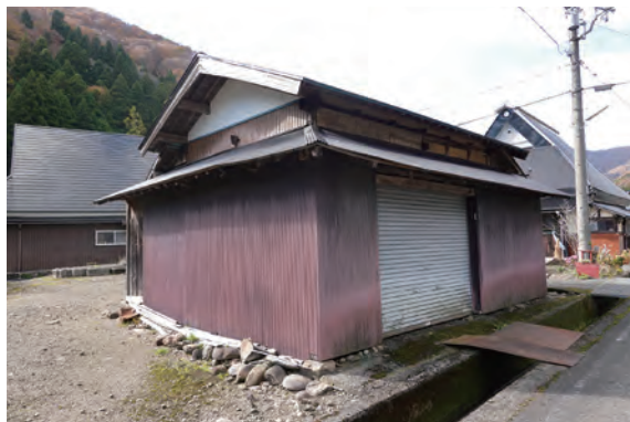
写真 3-4-45 隠居屋（035-1）外観（南東側）
