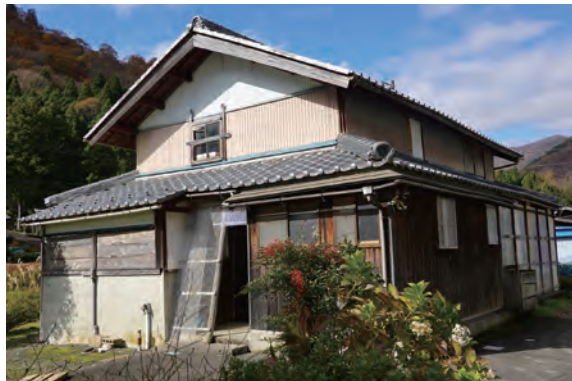
写真 3-4-33 主屋（026-1）外観（南東側）
