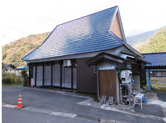
写真 3-4-47 主屋 (036-1) 外観 (西側)
