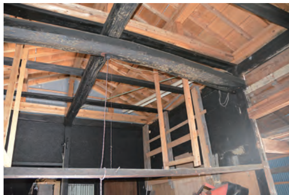
写真 3-4-46 隠居屋（035-1）小屋組
