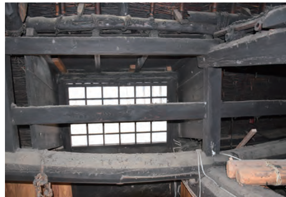
写真 3-3-3 明かり窓（内側）
