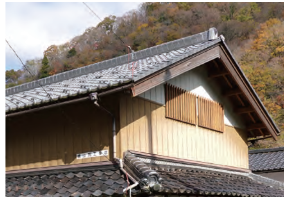
写真 3-1-6 切妻造・瓦葺
