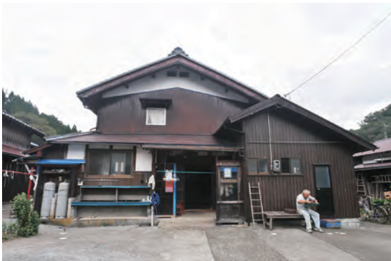
写真 3-4-29 主屋（024-3） 外観（南側）
