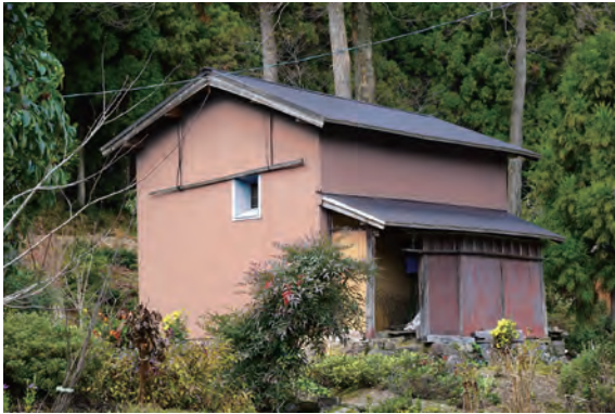
写真 3-4-22 土蔵 (019-3) 外観 (南東側)
