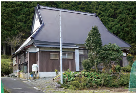
写真 3-4-20 主屋（019-1） 外観（東側）
