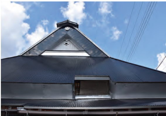
写真 3-3-2 明かり窓（外側）
