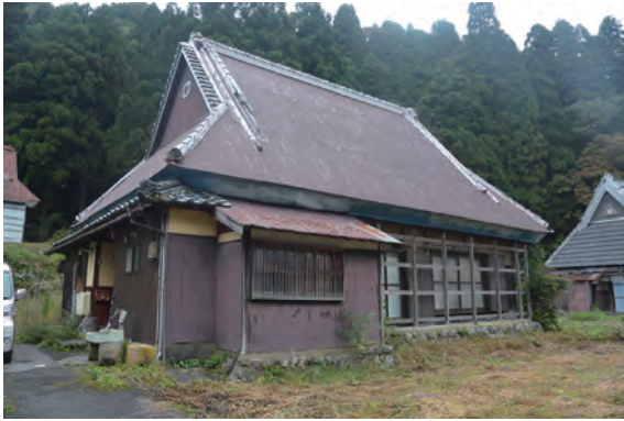
写真 3-4-14 主屋 (015-1) 外観 (東側)
