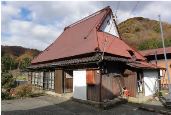
写真 3-4-37 主屋 (028-1) 外観 (南側)
