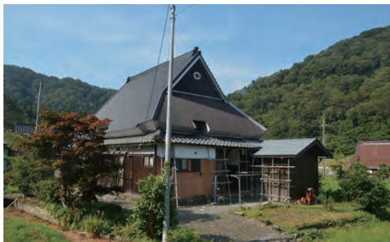
写真 3-4-18 主屋（017-1）外観（南側）
