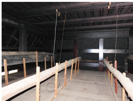
写真 3-4-48 主屋 (036-1) 土座上部
