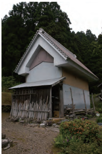
写真 3-4-16 土蔵 (015-4) 外観 (南東側)
