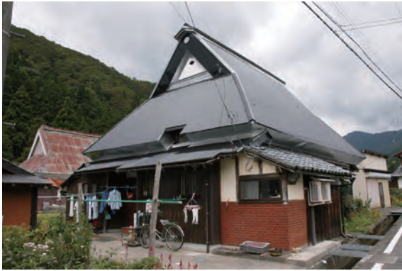
写真 3-4-43 主屋 (032-1) 外観 (南東側)
