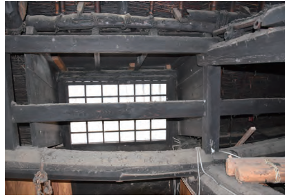
写真 3-4-2 主屋 (002-1) 明かり窓
