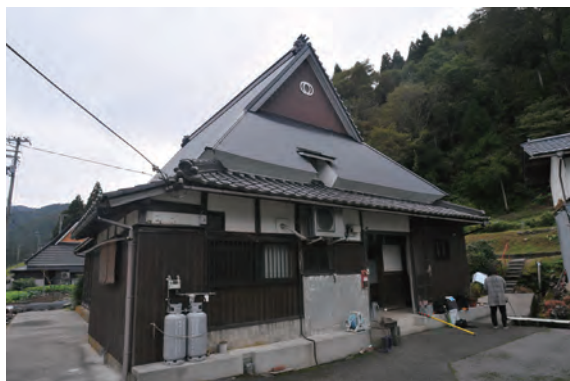
写真 3-4-65 主屋 (046-1) 外観 (南側)
