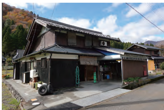
写真 3-4-9 主屋（004-1） 外観（南東側）
