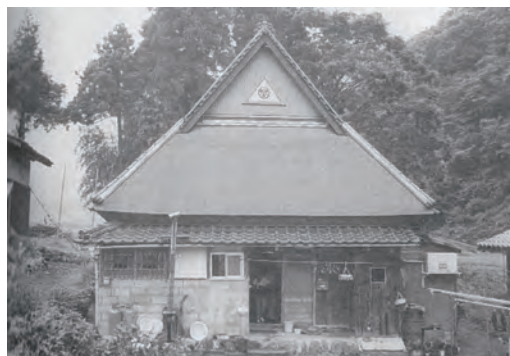
写真3-4-71 旧杉山久男家住宅・主屋 外観 (南側・現存せず)〔余呉町教育委員会1991〕
