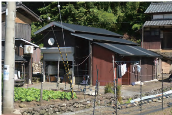
写真 3-4-63 倉庫 (045-2) 外観 (西側)
