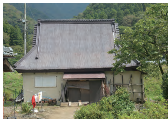
写真 3-1-8 金属板被せ茅葺の隠居屋（現存せず）
