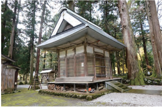
写真 3-4-83 六所神社・拝殿 外観（南西側）
