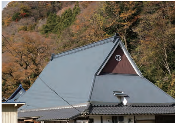
写真 3-1-5 入母屋造・金属板葺（元茅葺）
