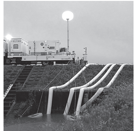
排水ポンプ車による排水作業
