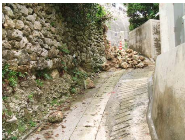
現場写真（石垣が崩壊し、道路の通行が不可となっている）
