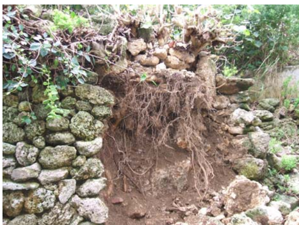
現場写真（石垣が崩壊し、道路の通行が不可となっている）
