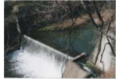
河川改修後の「樋の滝」 (下阿内町)
